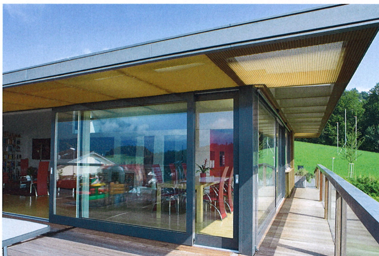
Der große Dachüberstand schützt den verglasten Ess- und Wohnbereich vor zu viel Sonneneinstrahlung.
